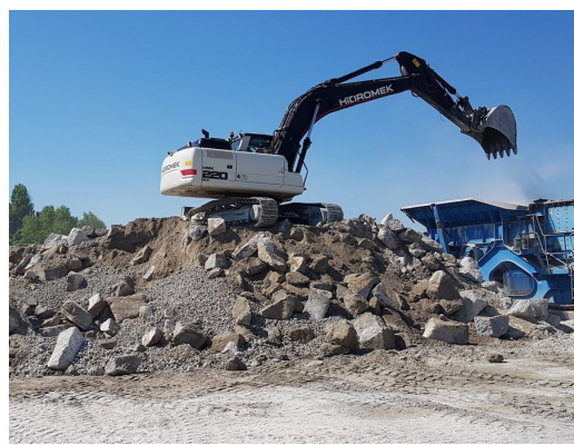
Concassage des déchets de béton
