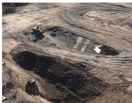
Vue aérienne des terrassements
