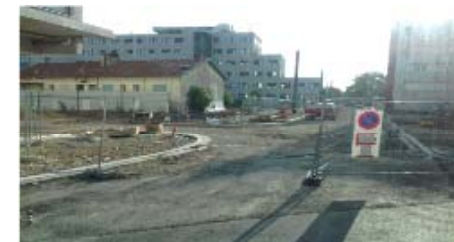
Réception des travaux
